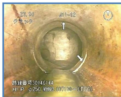
既設管渠の状況(カメラ調査結果)
