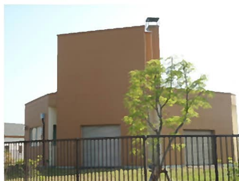
錦岡中継ポンプ場
