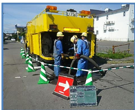
管渠清掃作業の様子
