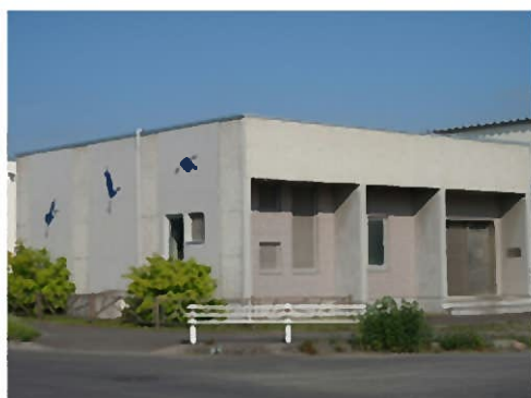
明野中継ポンプ場
