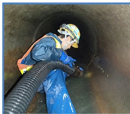
管渠清掃作業の様子(管内)
